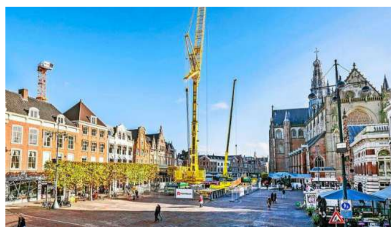
2022: Hijsen van de grote kraan op het Brinkmann-complex.
